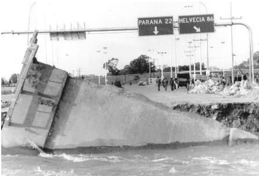
(6) 1983 – El aliviador N°4 en la Ruta 168 entre Santa Fe y Paraná, fue dinamitado para descomprimir la fuerza del agua.
