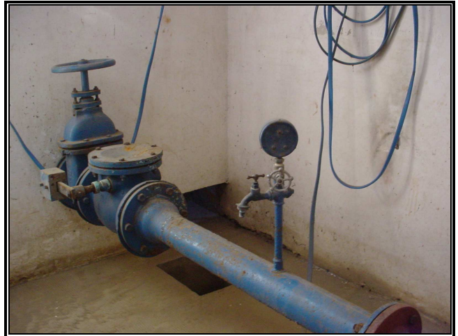
Foto 22. Bomba N° 4 que abastece a la red de agua
