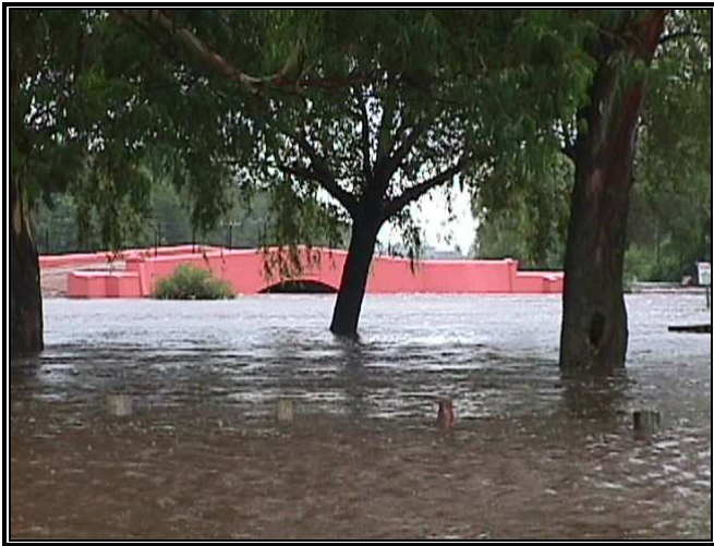
Foto 24. Puente Viejo – febrero 2003.
