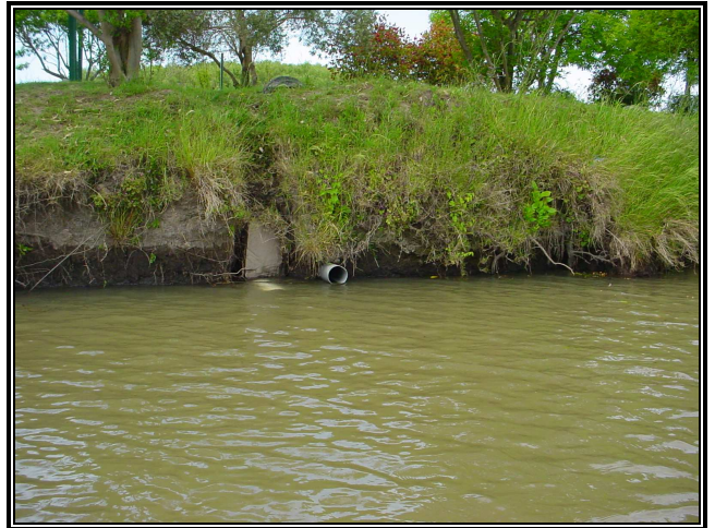
Foto 10. Caños de desagüe del Club de Pescadores
