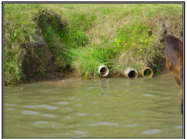
Foto 11. Caños de desagüe del Camping Club River
