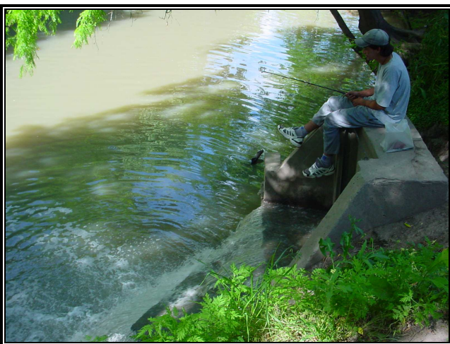
Foto 14. Desagüe de la planta de tratamiento de residuos cloacales
