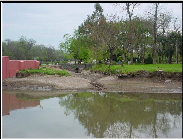
Foto 13. Desagüe pluvial del barrio Canuglio
