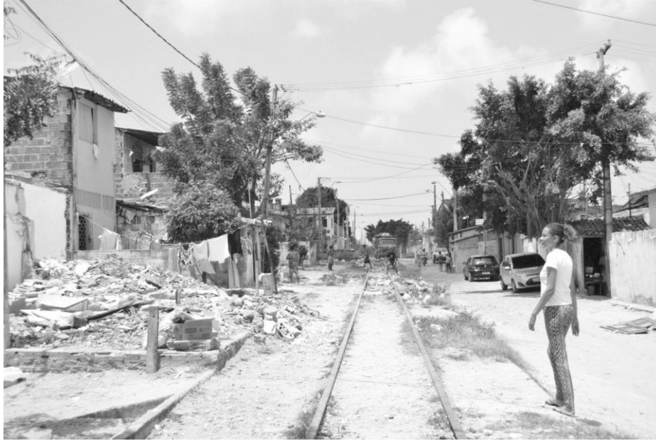
Imagem 05: Demolições provocadas pela implantação do VLT I maio/2016 (Fonte: Autoras)
