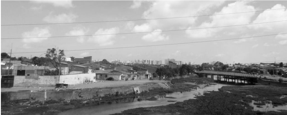
Imagem 01: Lagamar visto do viaduto I janeiro/2017 (Fonte: Autoras)
