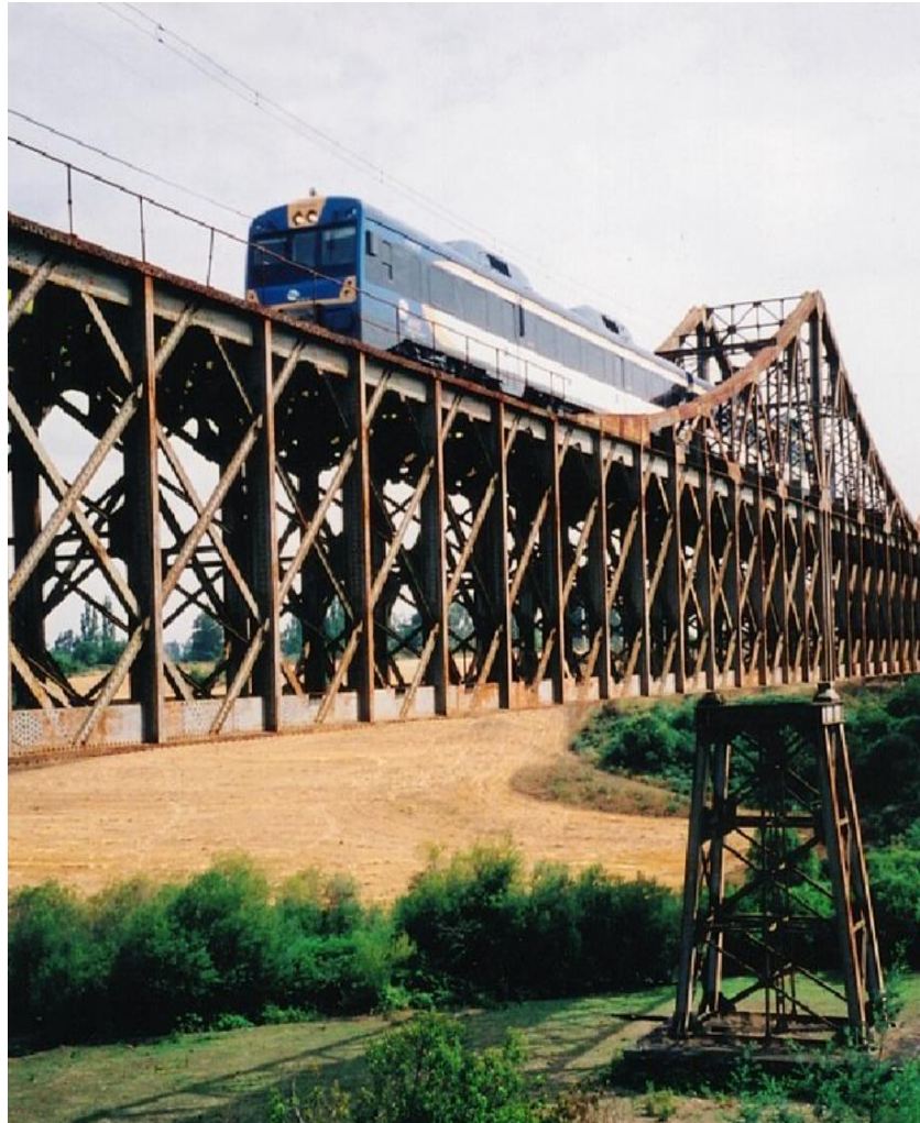
Descripción: Ferrocarril de La Araucanía atravesando el Puente Quillén. Fotografía realizada por Sergio Soto (2008). Extraída de http://www.trenesdechile.cl/
