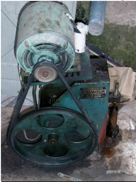
Barrio: Parque Las Acacias, perforación en uso, 30 metros de profundidad, y 20 años de antigüedad. Uso familiar
