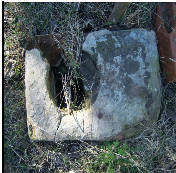
Barrio: Las Acacias, perforación de 24 metros que albergó un “bombedador” durante 20 años, quedo abandonada sin cegar desde hace 10 años.
