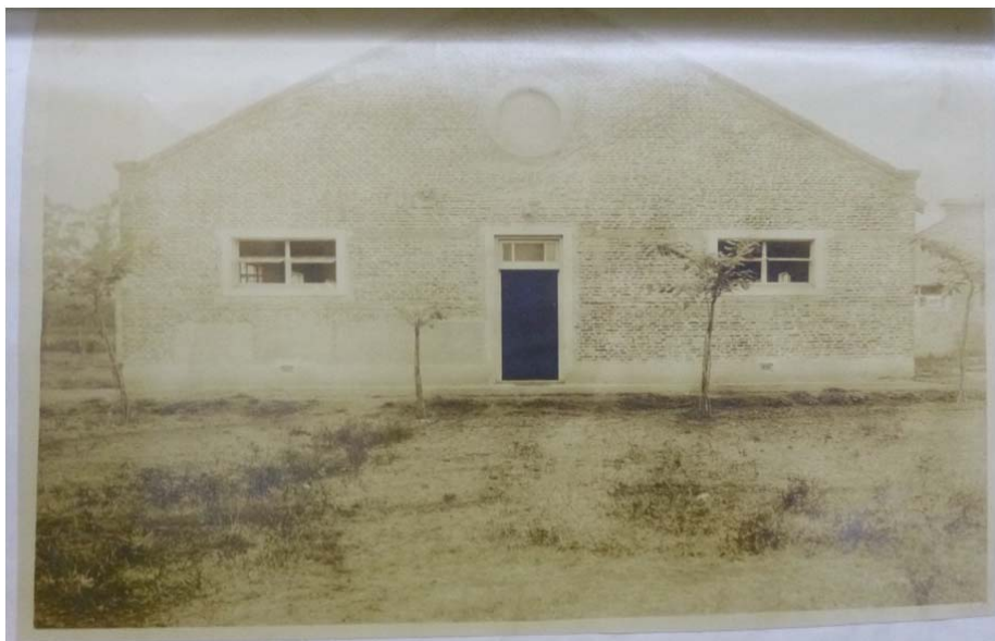
Figura N° 2: Barraca dormitorio construida en 1923
