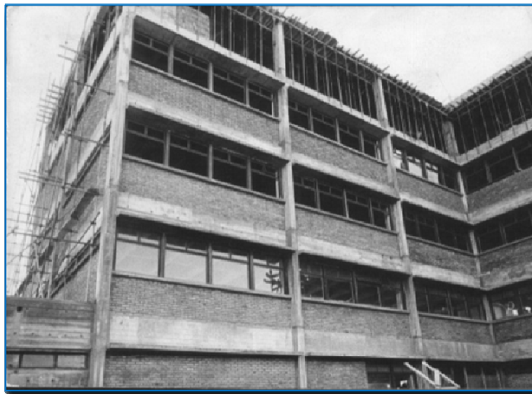
Construcción del tercer piso del Colegio Nacional Mixto de Morón hacia 1969 ( parte trasera del edificio)
