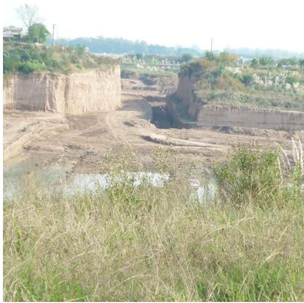
Extracción de tosca y limos loésicos para rellenos y cimentación de caminos.
