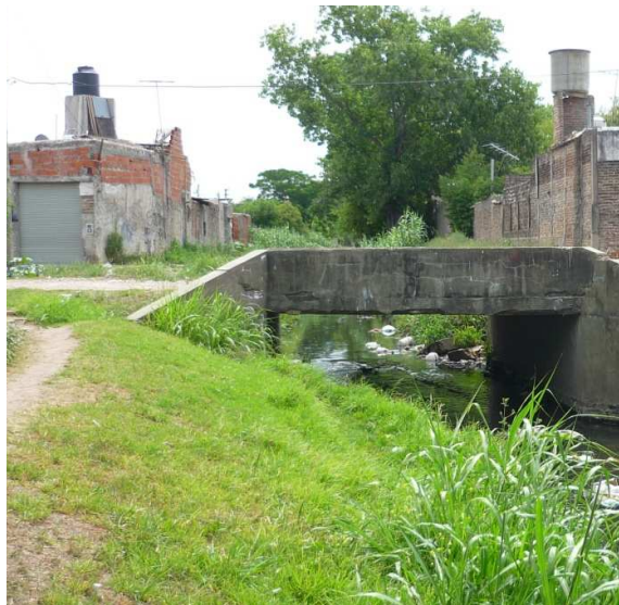
Arroyo en el periurbano de la cuenca media. Se observan viviendas ubicadas sobre sus márgenes.
