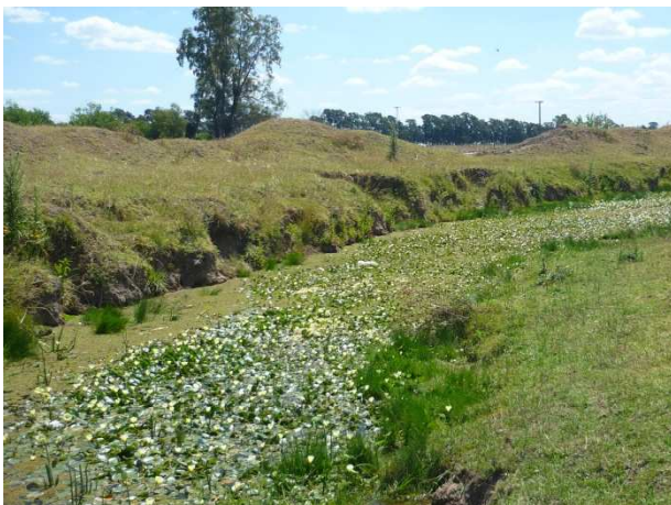
Dragado de un arroyo en la cuenca alta. Se observan los montículos, consecuencia de esta transformación.
