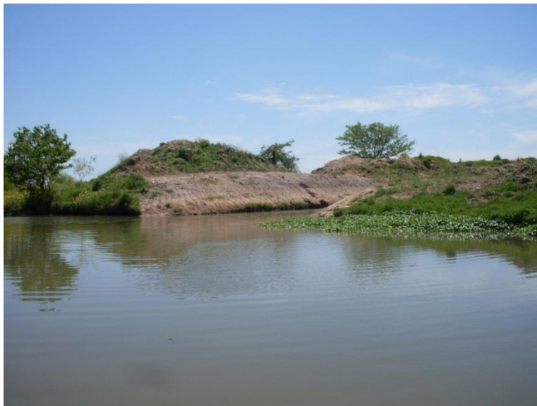
Figura 1.5. Canal abierto transportando agua residual mixta de industrias alimenticias, correspondiente al sitio EC2.
