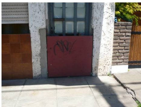
Foto 18. Vivienda con compuerta
