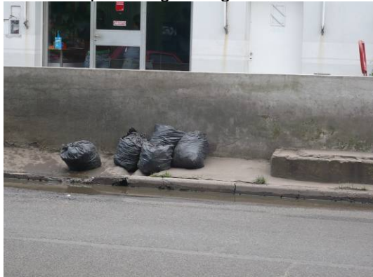
Foto 20. Frente de un negocio con una pared para evitar que las aguas ingresen al local.
