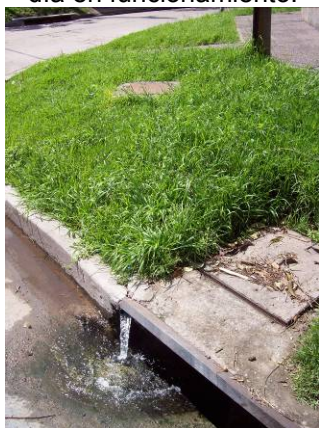
Foto 16. Bombas ubicada en Céspedes y Dinamarca, esta se encuentra gran parte del día en funcionamiento.
