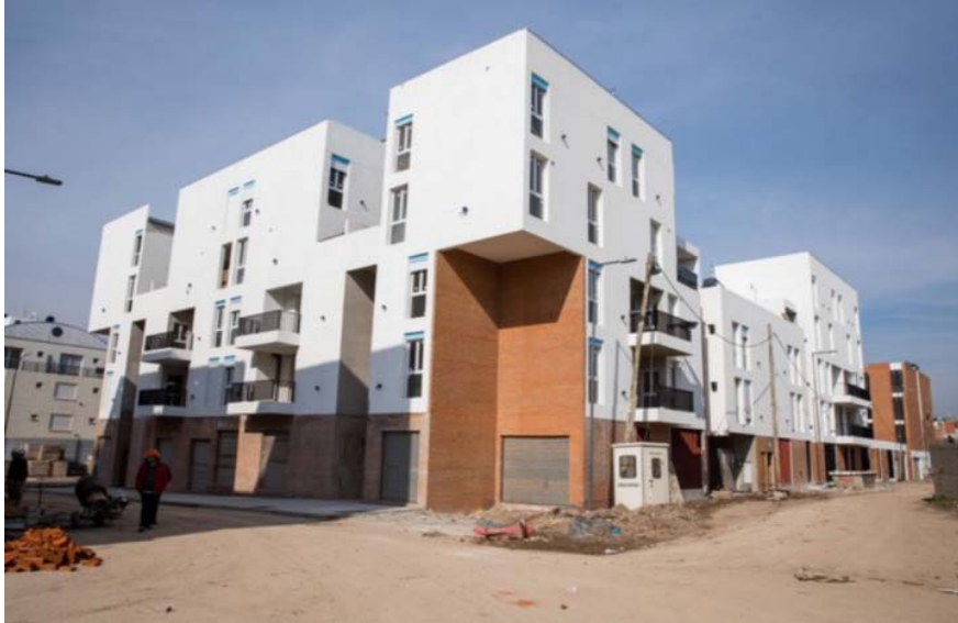
Fig. 125: Imagen exterior de la manzana 6 de la etapa 6. Recuperado de https://www.buenosaires.gob.ar/baobras/barrio-papa-francisco
