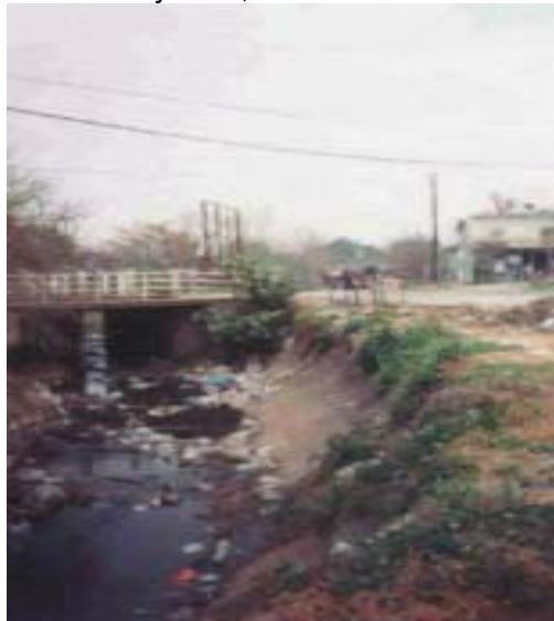
Foto 16 Puente de la calle Villegas y Arroyo Soto
