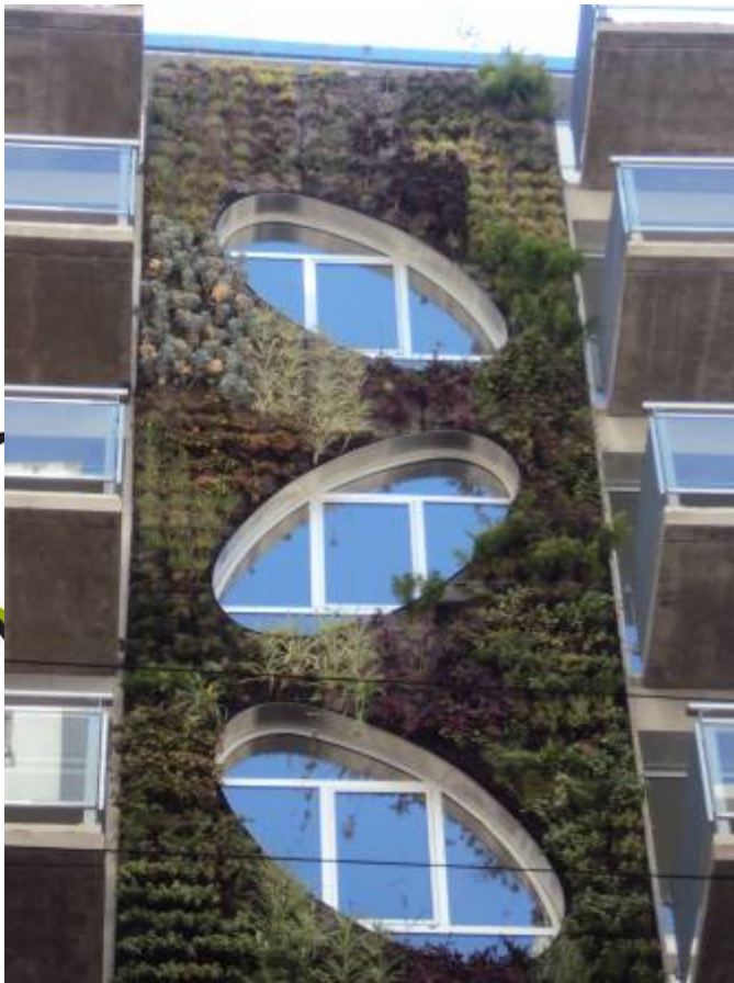
Imagen del muro vegetado correspondiente a febrero de 2012
