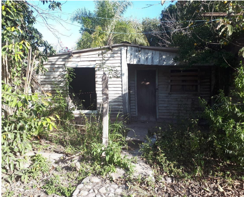
Imagen 115. Viviendas abandonas Lote El Puesto
