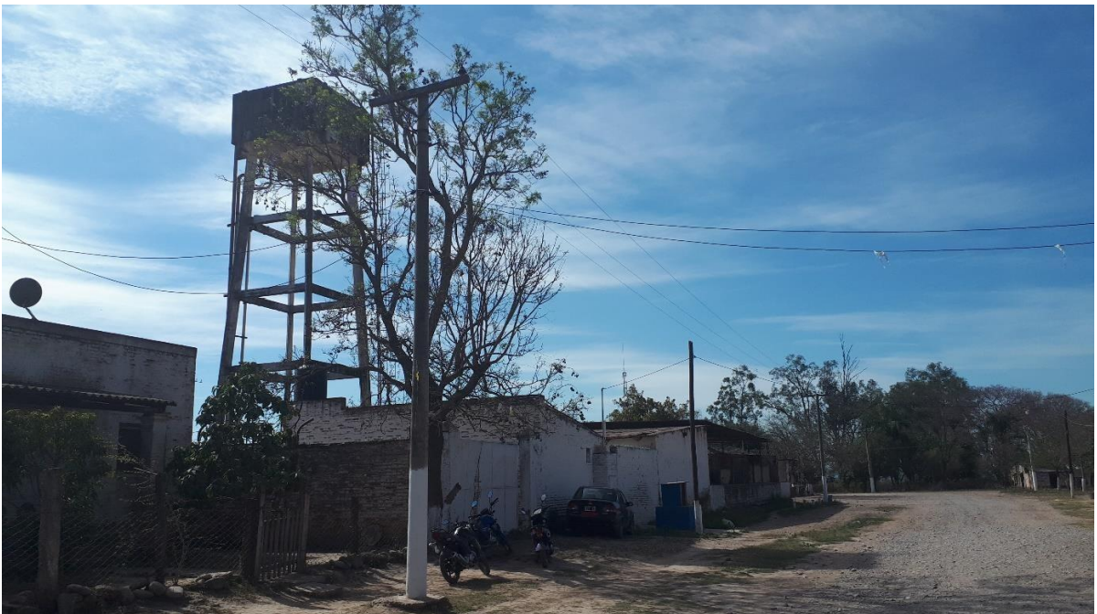
Imagen 125. Tanque de agua
