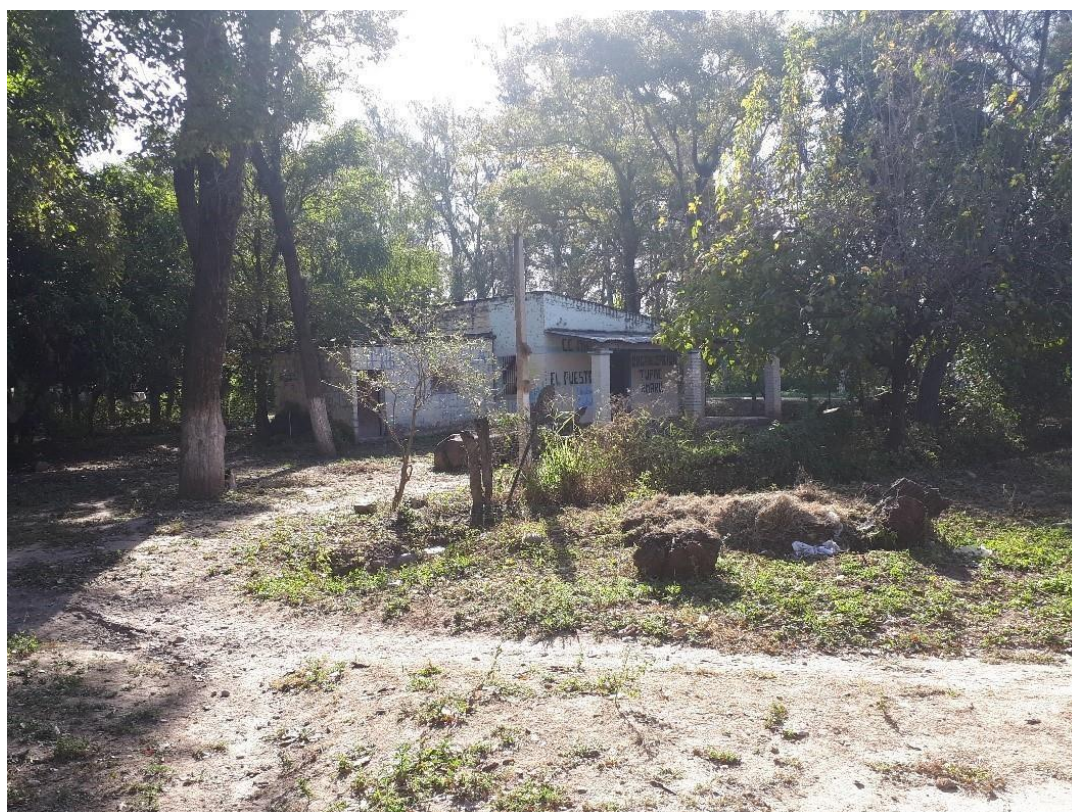
Imagen 105. Viviendas construidas de material
