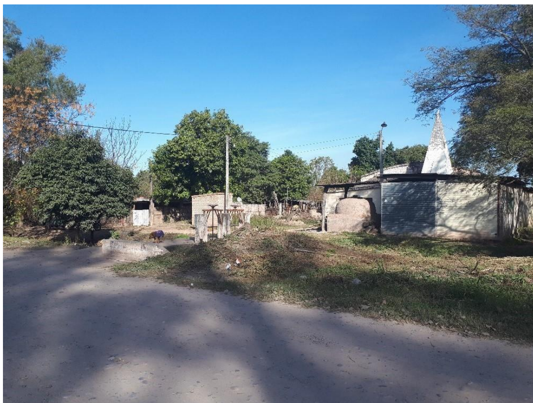
Imagen 104. Viviendas construidas de material
