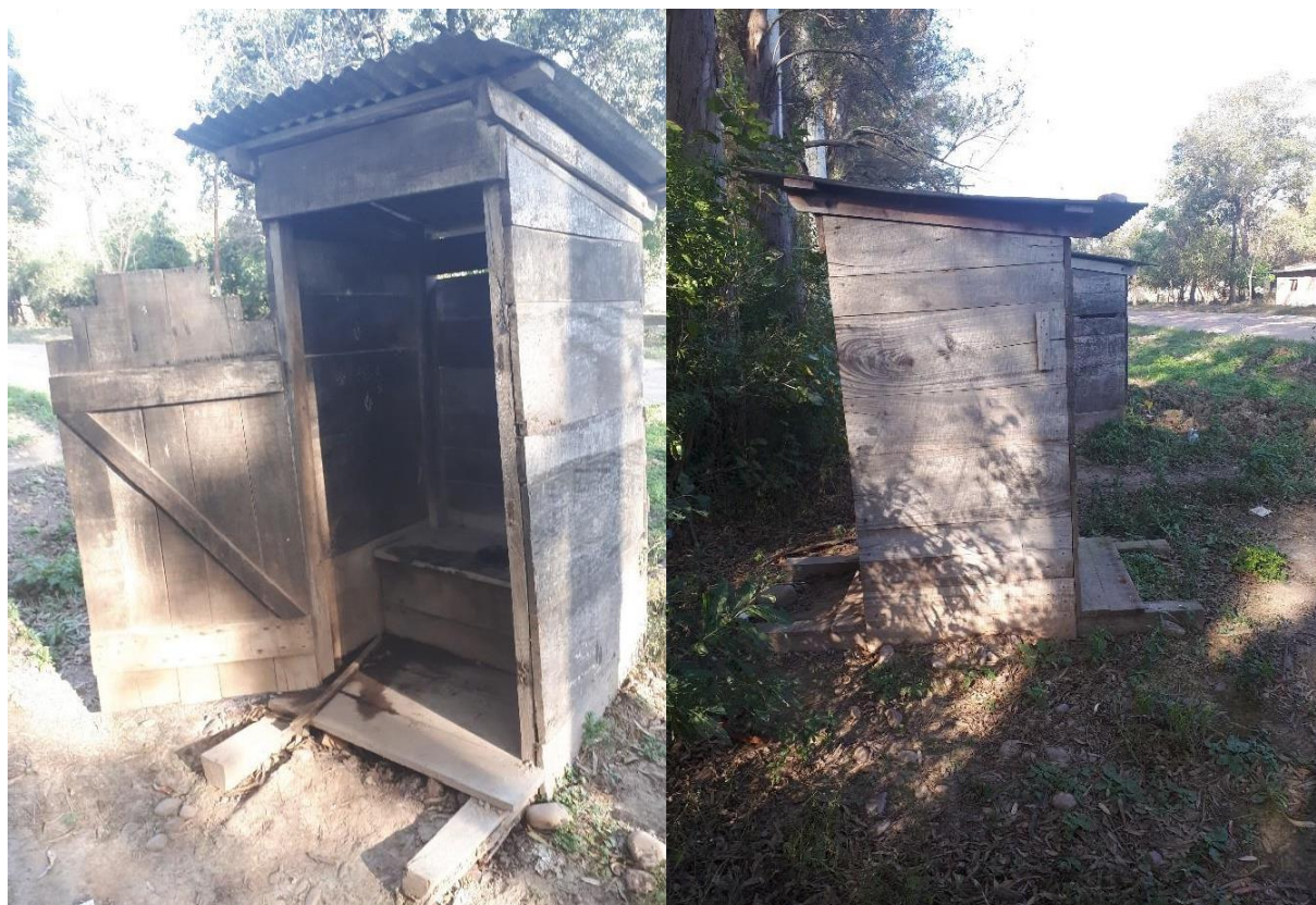
Imagen 113. Baños comunitarios Lote El Puesto
