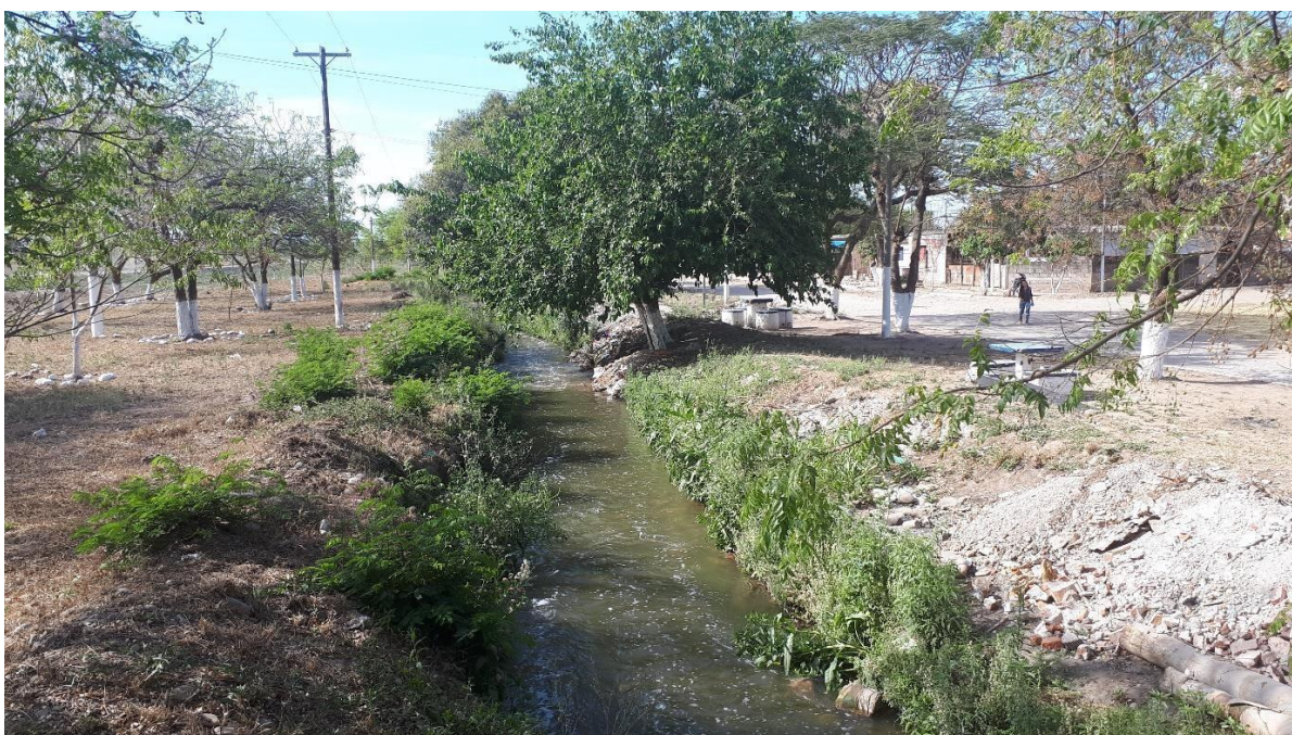
Imagen 123. Canal de aguas servidas
