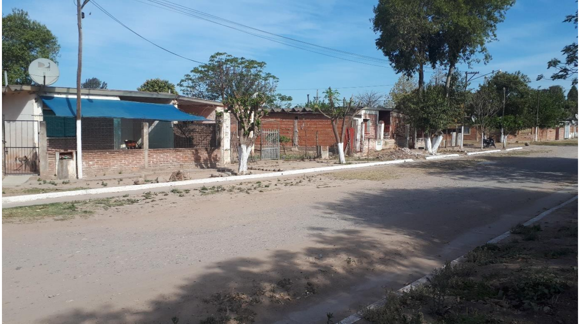
Imagen 119. Viviendas de material Lote Arrayanal
