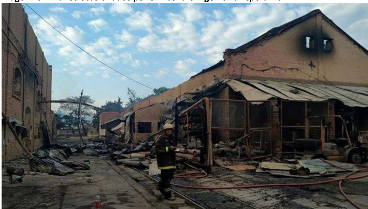
Imagen 137. Daños ocasionados por el incendio Ingenio La Esperanza
