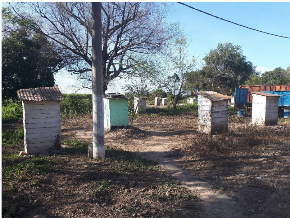
Imagen 111. Baños comunitarios Lote El Puesto (Sector viviendas con material)
