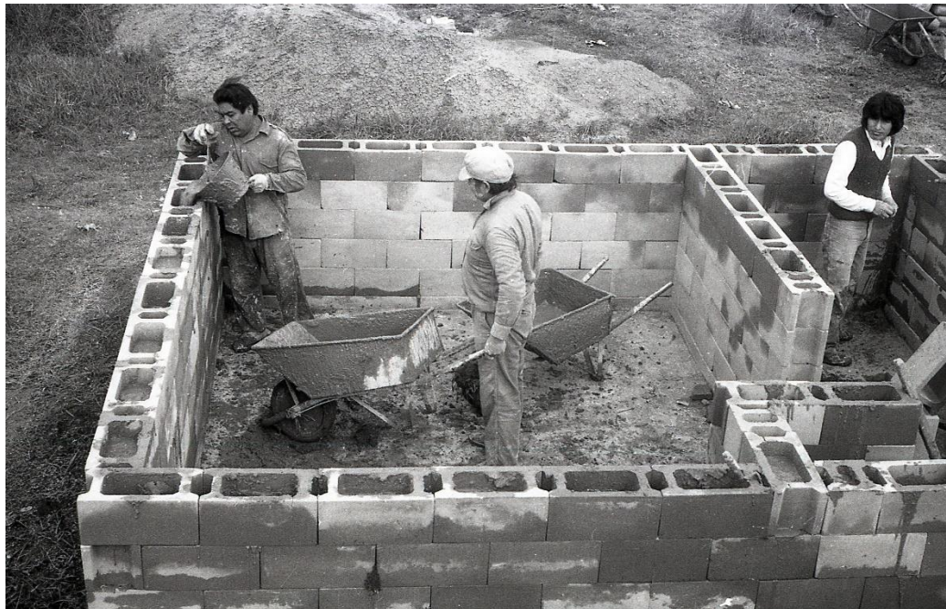
Imagen 6: Elevación y llenado de la mampostería de una vivienda, mayo de 1979 (Archivo FVC).
