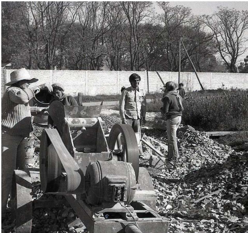
Imagen 12: Trituradora de cascotes en la obra, diciembre de 1978 (Archivo FVC).
