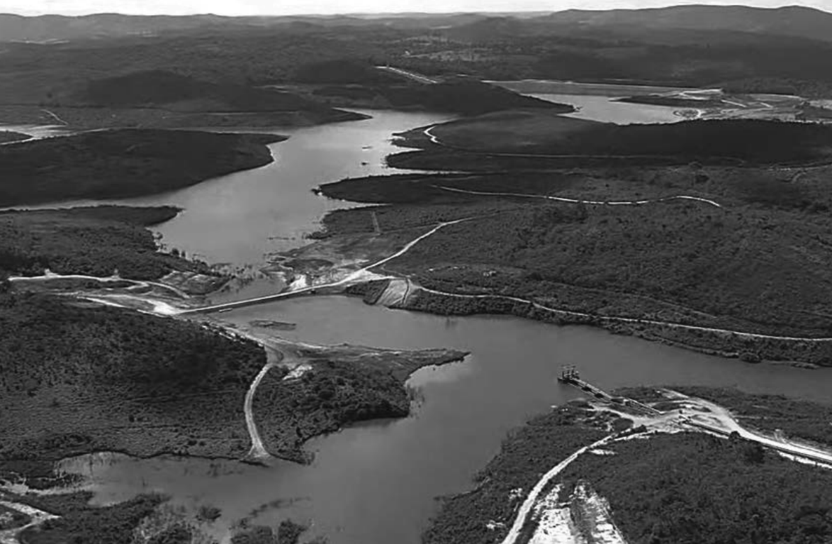
Projeto Minas-Rio, barragem de rejeitos. Fonte: Anglo American, 2014.
