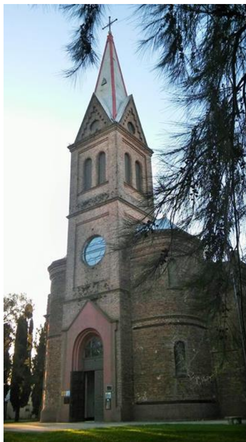
Imágenes de la Iglesia (fuente propia)
