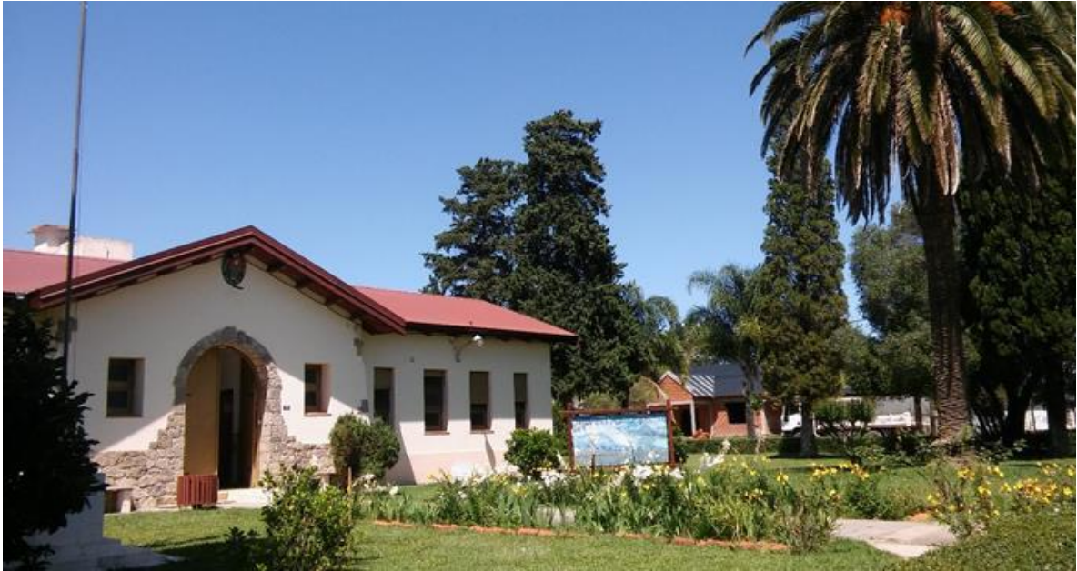
Imagen del Hospital Provincial Padre Becher (fuente propia)
