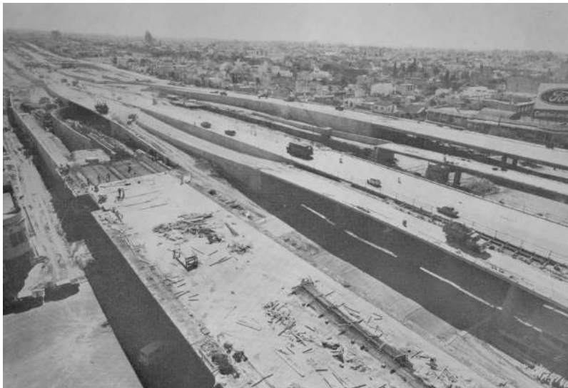
Figura 34 Aspecto general del distribuidor de tránsito sobre Avenida Cabildo-Maipú, 1972
