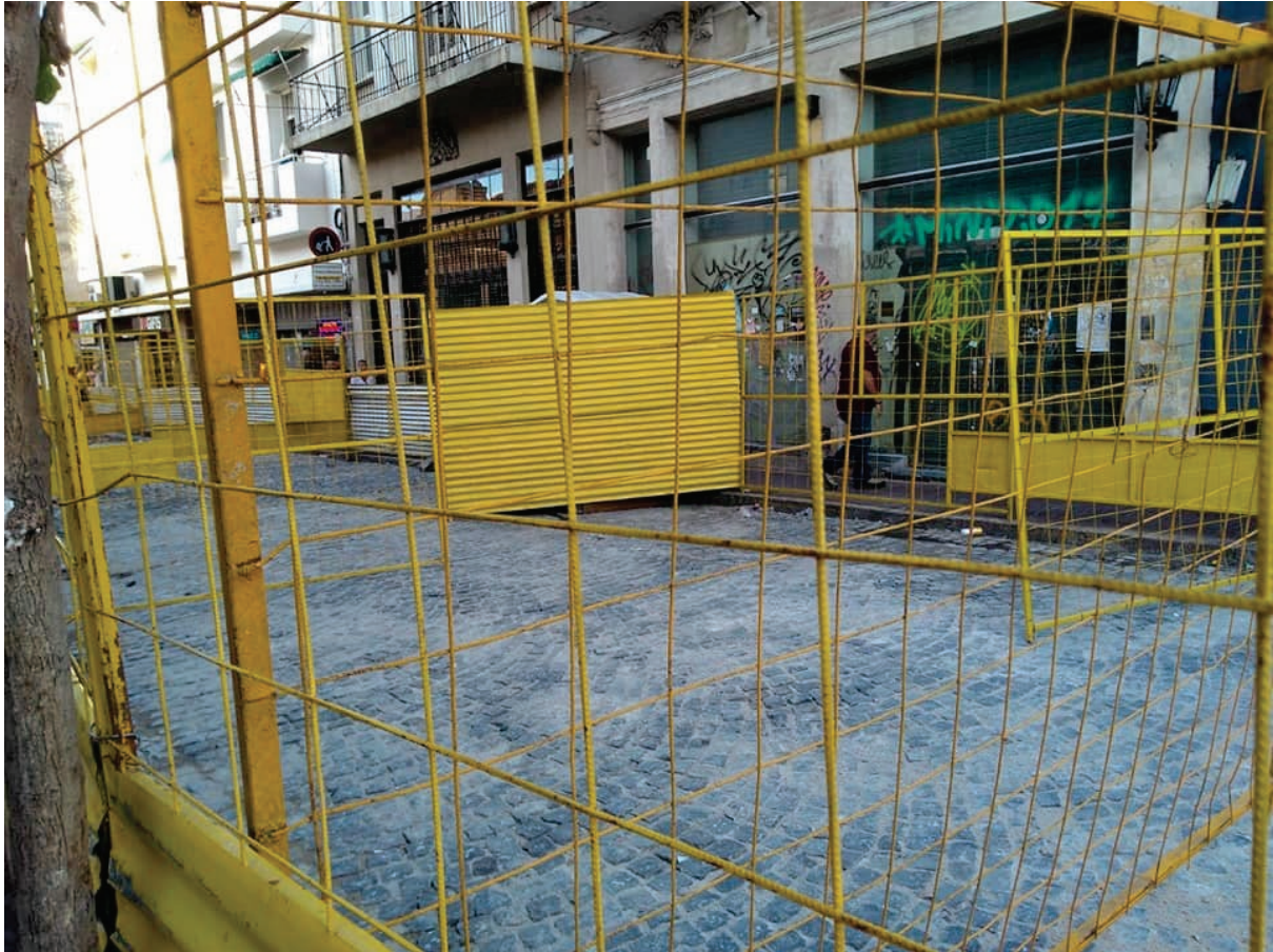
Figura 3: Vallado por obras de readoquinamiento en calle Defensa, San Telmo. Fuente: Página de Facebook de AUCD.
