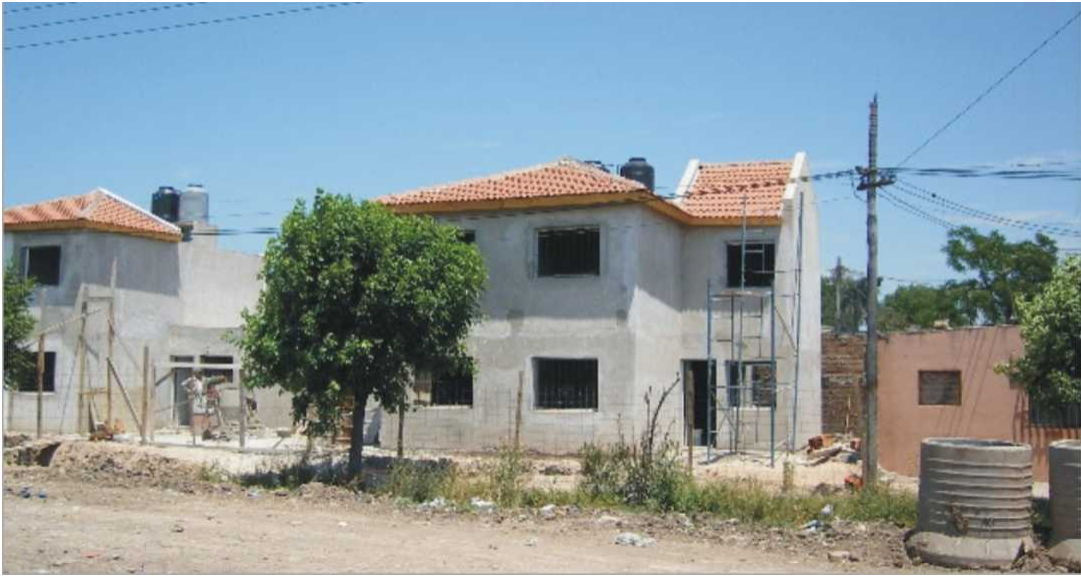
Casas en construcción.
