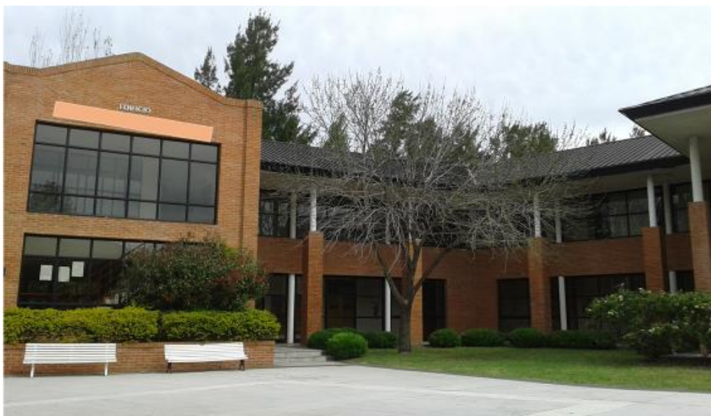
Imagen 5: Edificio A de costado y vista del patio central
