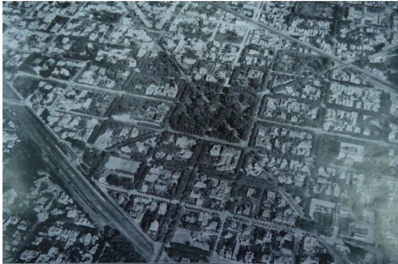
Imagen 8 : Vista aérea de la Plaza General Arenales y alrededores
