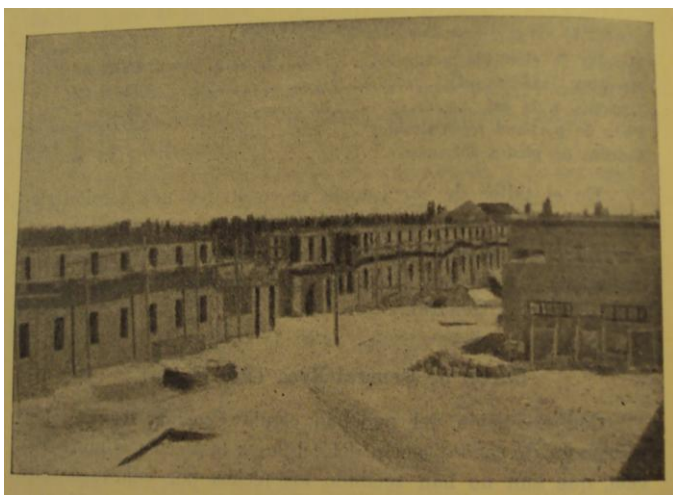
Foto 5. “Cárcel de General Roca (Río Negro). Estado del edificio en construcción de la nueva Cárcel. Cuerpo celular interior y patio lado norte. – 31-XII-1938”. Ministerio de Justicia e Instrucción Pública, Memoria presentada al H. Congreso de la Nación. Año 1938 , Buenos Aires, 1939, p. 420
