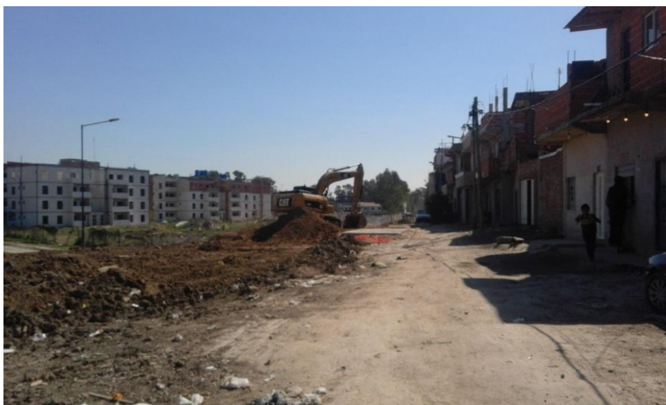
Foto 12: La Villa 21-24 y las obras de "Mundo Grúa" (Carla Fainstein, 2016)
