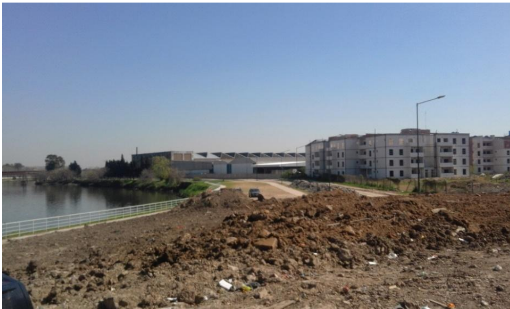
Foto 11: "Mundo Grúa", una de las obras para las nuevas viviendas de los habitantes del "camino de sirga" de la Villa 21-24 desde San Blas, uno de sus sectores (Carla Fainstein, 2016)
