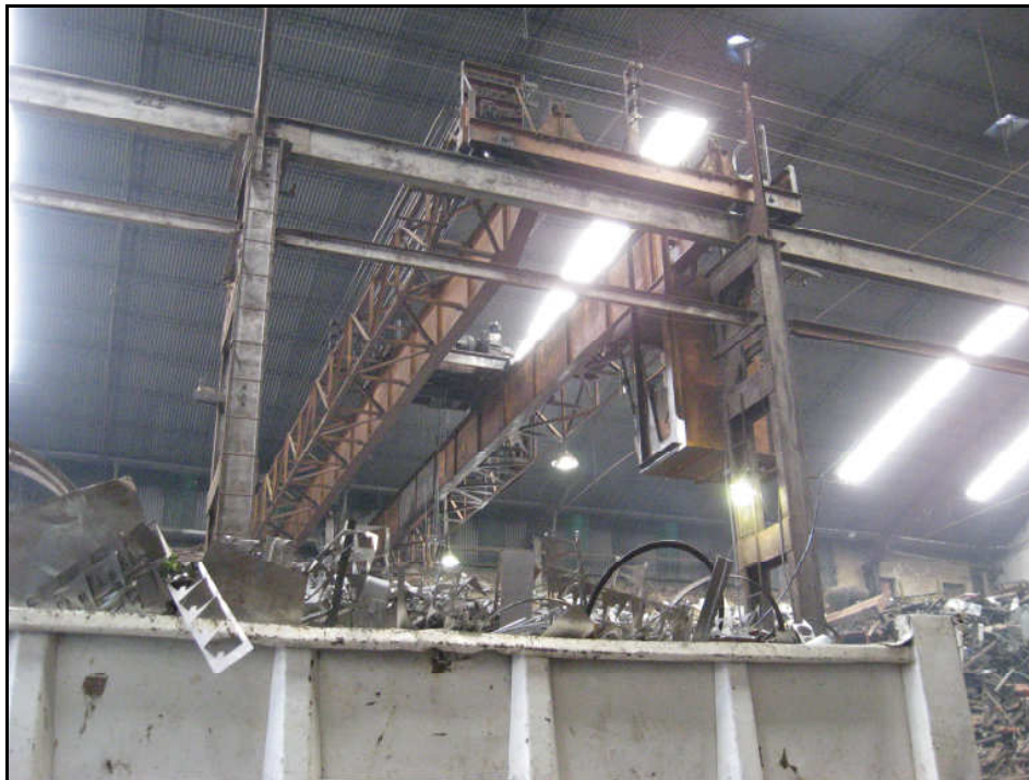
Foto N°10: Puente Grúa utilizado para carga/descarga de material en camiones. Fuente: Relevamiento de campo (2007)
