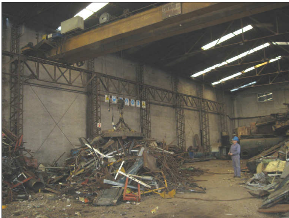
Foto N°18: Puente Grúa con electroimán, puesto en funcionamiento por un operario. Prensadora de Zona Noroeste de RMBA. Fuente: Relevamiento de campo (2007)
