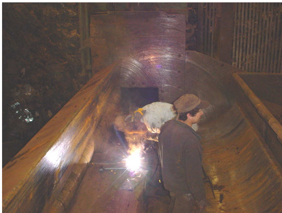
Foto N° 21: Trabajadores de una prensadora, reparando una cizalla – Zona Sur Fuente: Castillo, M. (2005).
