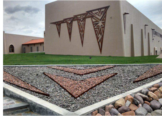
Vista lateral de la bodega. Disponible on line.
