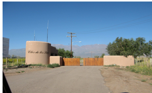
Garita de seguridad. Foto propia (febrero, 2011)
