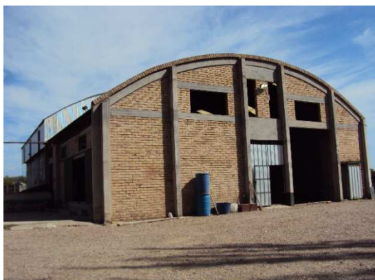
Vista frente de la Bodega (Fotos propias, 2010)
