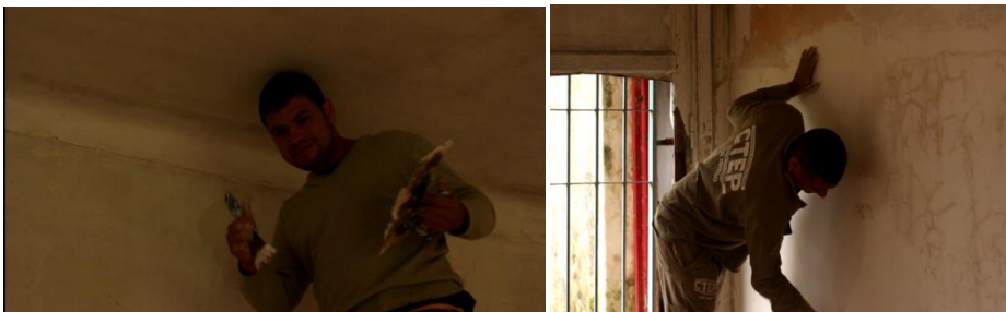
7 de Octubre 2019. Foto: propia. Cooperativista trabajando en la obra del nuevo espacio del EPI
