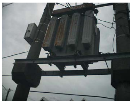
Foto nº - 18. Aguas Argentinas 1734 entre Ratti y Darbon. Salida de Campo sábado 8/11/03 Bº San Alberto
